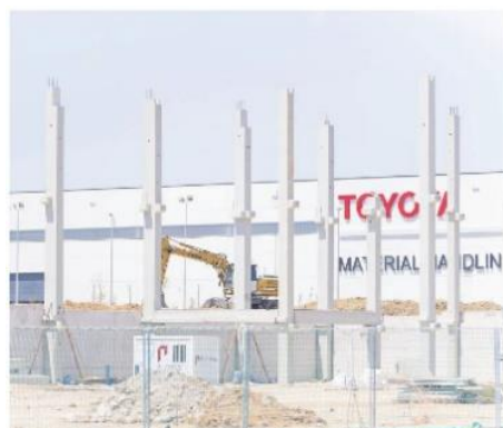
Procés de construcció
