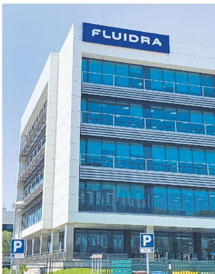
La seu central de la companyia Fluidra, ubicada a Sant Cugat del Vallès / ACN
